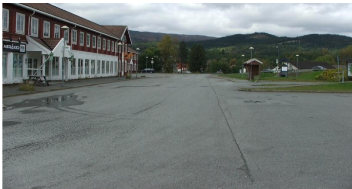
- Næringsbygget sett mot nord
